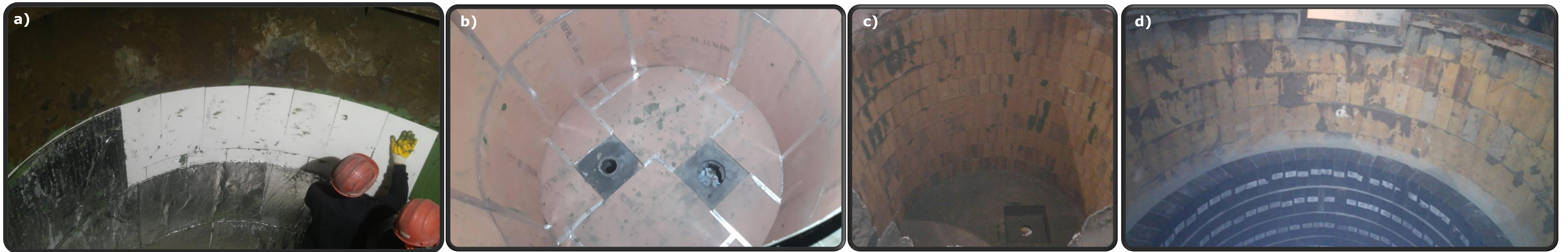
Şekil 3. Şekil 1c/2c'de tanımlanmış izolasyon konfigürasyonunun uygulama görselleri a) mikroporoz, b) nefalit, c) emniyet tuğlası ve d) MgO-C/dolomit tuğla uygulamaları
