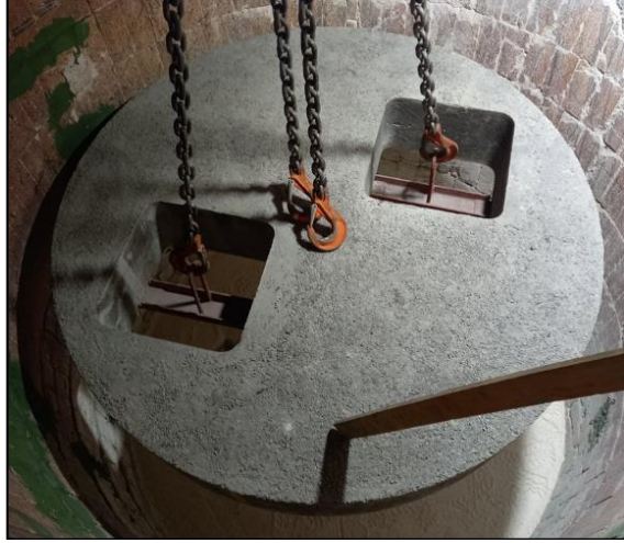
Şekil 2. Prefabrik blok görünümü
