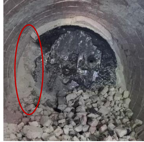
Şekil 6. Taban sökümüne başlangıç noktası
